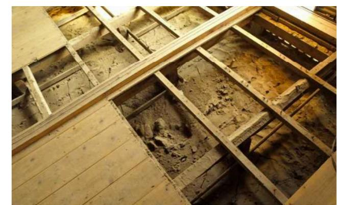
床の被害は、浸水や泥による床板の汚損、破損、浮き上がりや沈下、畳が水を吸ったことでの膨張などが生じます。
