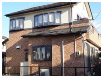
写真 4-1 世帯 A の再建された住宅
