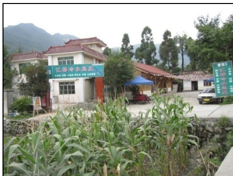
【写真 9】小漁洞鎮江橋村の現地再建店舗兼住宅
