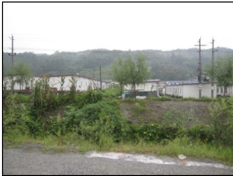
【写真 7】通済鎮花溪村の仮設住宅
