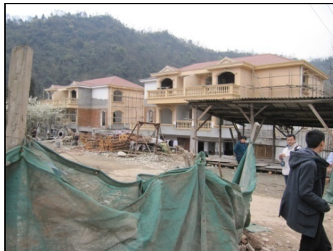
【写真 12】茶坪村開発再建方式で建設中のホテル
