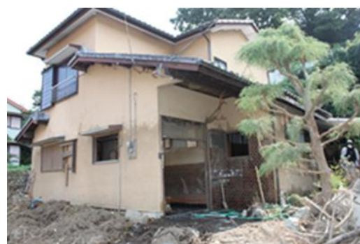
図5 1階天井付近まで浸水。宅地内にも数十センチの土砂が堆積。
