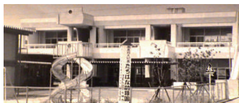
昭和45年 園舎全景
