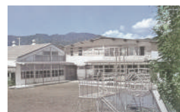
昭和41年 園舎全景
